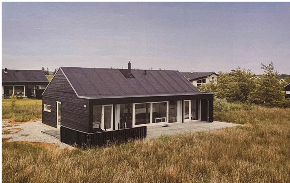
Det nye hus opføres i denne stil med sort træ, hvide vinduer og sort tagpap
